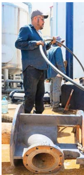
CON REPARACIÓN DEL POZO 17
