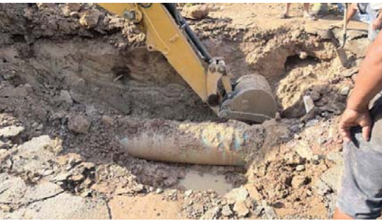
Arreglan ruptura en línea principal
