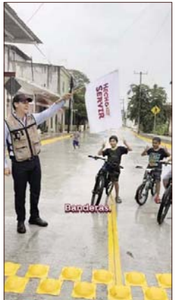
Para el arranque de obra.
